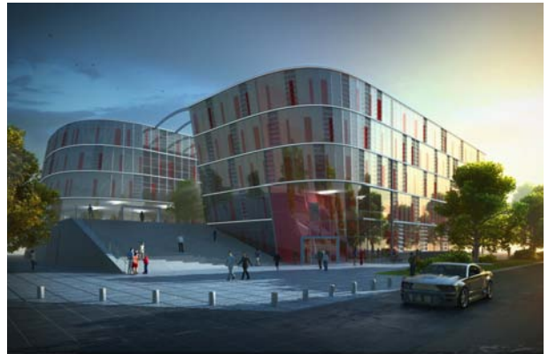
Büro- und Laborgebäude, Dubna
